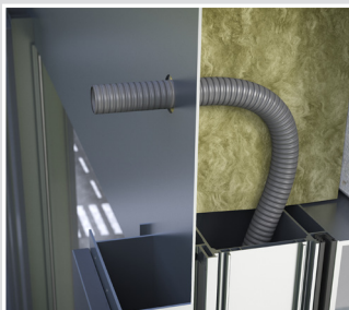
De beschermingsmantel (20-21,2 mm) door de gevel halen
