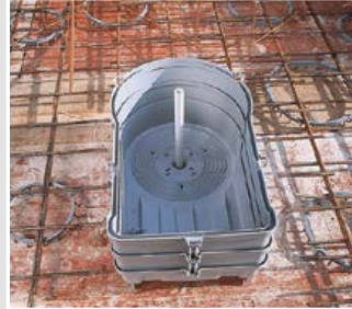
Fixer le boîtier avec les 2 rehausse et le support à l'armature.
