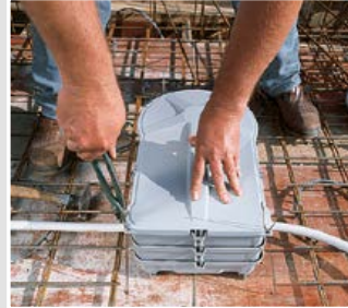
Fixer également le boîtier à l'armature.
