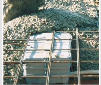
Installation fiable et stable du boîtier lors du bétonnage.
