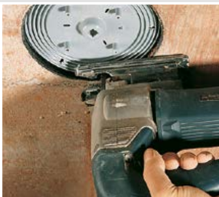
Ouvrir la coiffe avant à l'aide d'une scie à guichet.
