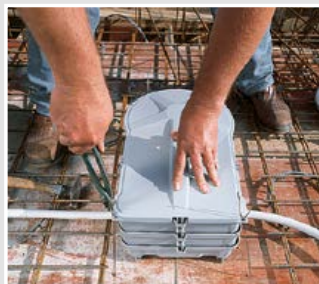
Maak de behuizing bijkomend vast aan de bewapening.
