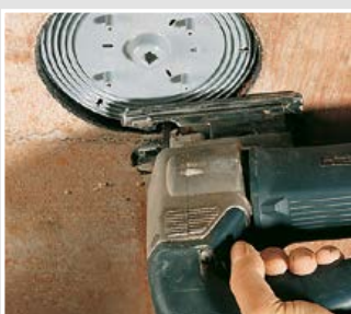
Front openen met behulp van een decoupeerzaag.
