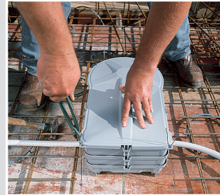
Gehäuse zusätzlich an der Bewehrung sichern.
