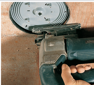
Frontteil mit einer Stichsäge öffnen.
