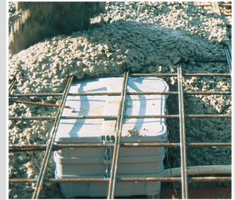
Sicherer und fester Sitz der Gehäuse beim Betonieren.
