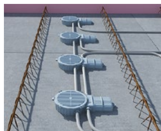
Dopo la posa dei tubi, effettuare una gettata in cantiere di calcestruzzo allo spessore desiderato.
