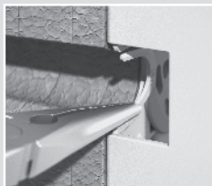
Bei der Montage von Rohren M25 muss vorgängig der Reduktionsring am Frontelement entfernt werden.
