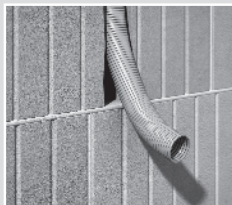
Backsteinmauer mit Rohraustritt.
