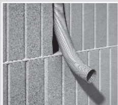
Mur en brique avec sortie de tube.
