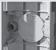
Dübelabdeckung wieder anbringen - ein "Klick" muss hörbar sein. Rohrenden werden abgedeckt.
