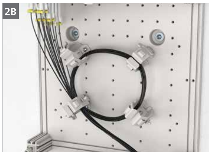
Kundenkabel vom Mikrorohr strukturiert durch einen Sammelhalter führen und daran fixieren.
