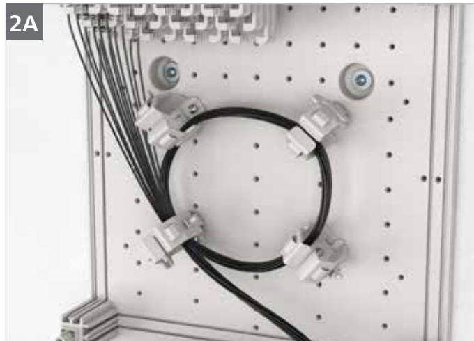
Kundenkabel vom Mikrorohr strukturiert durch einen Sammelhalter führen und daran fixieren.
