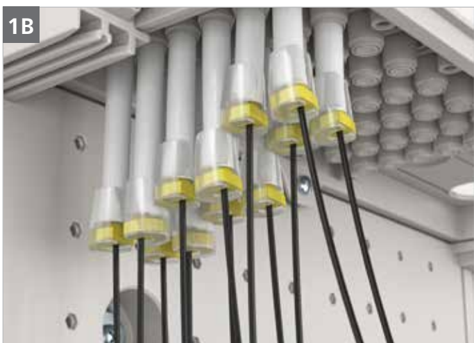
Die einzelnen Mikrorohre mit Gasblocker verschließen.
