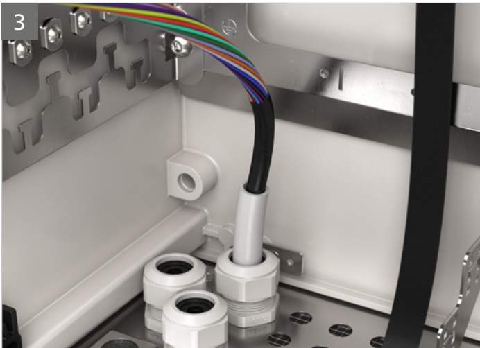
Hauptkabel auf die passende Leitungslänge absetzen.
