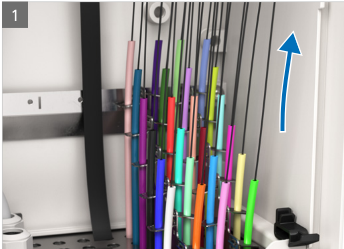
Kunden-Kabel durch Mikrorohre einblasen.
