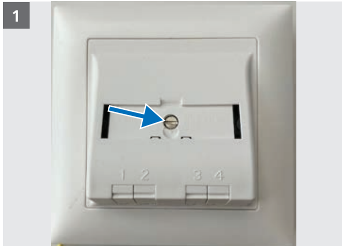
Abdeckrahmen und Abdeckung abschrauben.
