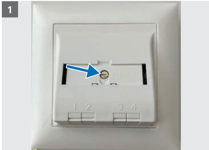
Abdeckrahmen und Abdeckung abschrauben.
