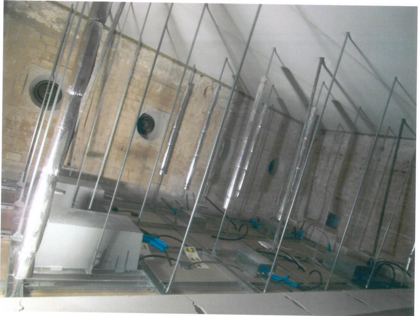
Probekörper vor dem Brandversuch am 01.07.2015 Ansicht Feuerseite
