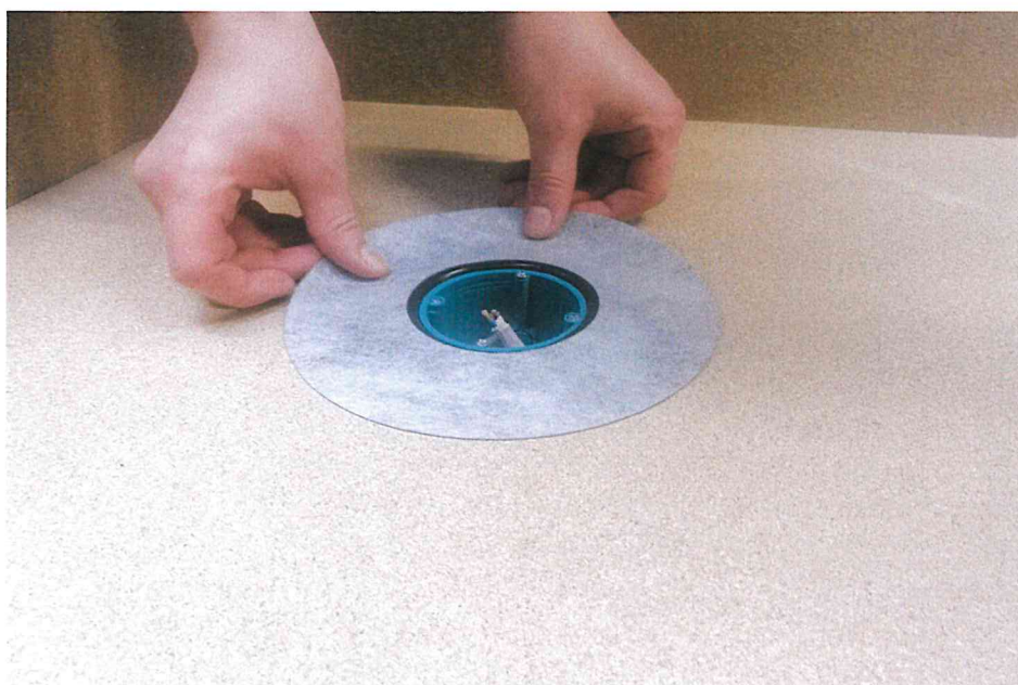
Bild 4: Verkleben der Manschetten am Untergrund nach Entfernen der rückseitigen Abdeckung
