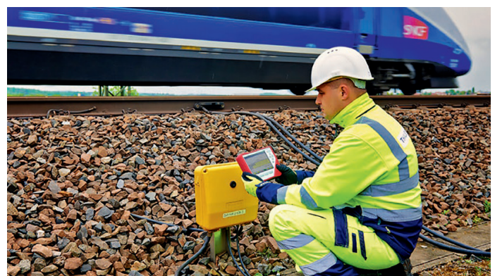
Achszähler / Axle counter
