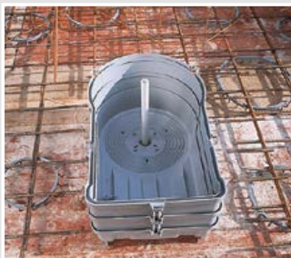
Bevestig de behuizing met 2 tussenkaders en een steunbuis op de bekisting.
