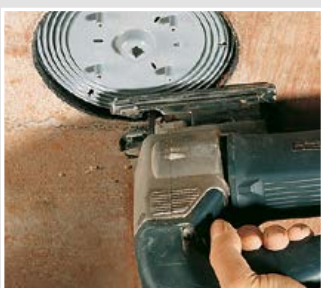
Front openen met behulp van een decoupeerzaag.
