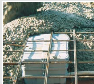
Veilige en vaste positie van de behuizing bij het betonneren.
