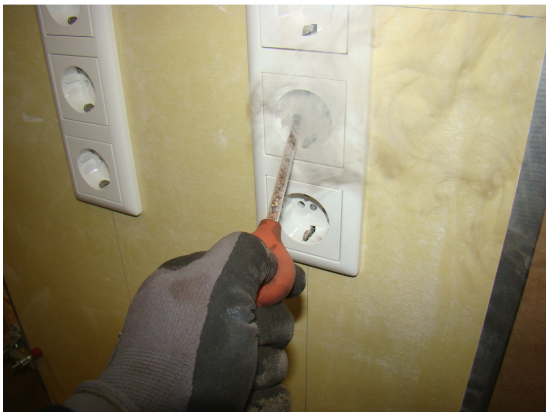
Foto B.4 S 200 test, onderzoek naar lekkages
