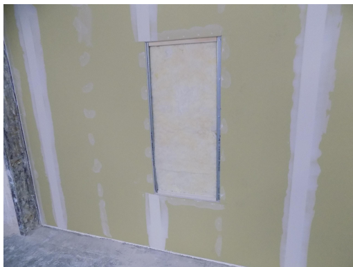
f3 afbeelding van de mineraalwol in de spouw van de wand ter plaatse van de inbouwdozen
