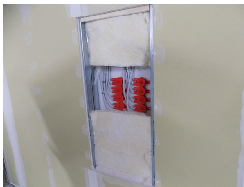
f3 afbeelding van de mineraalwol in de spouw van de wand ter plaatse van de inbouwdozen
