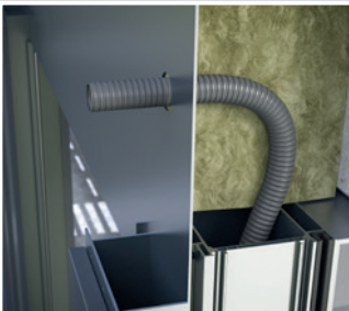
Schutzschlauch (AD 20 - 21.2mm) durch die Fassade führen
