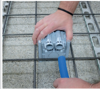
und die UP-Abzweigdose mit den KRFG-Rohren verbunden.
