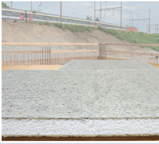
Die Schalung wird mit Dämmstoff belegt.
