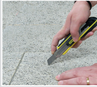
Der Installateur erstellt einen Ausschnitt für die Dose
