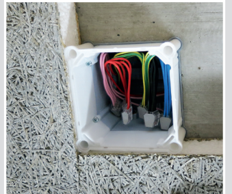
Die Isolation kann angebracht werden.
