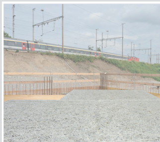
L'isolation est posée sur le coffrage.
