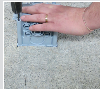
Clouer la boîte sur le coffrage.
