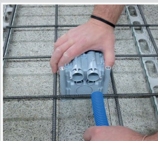
Innestare i tubi THFWG nella scatola di derivazione.
