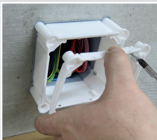
Eventualmente impilare altri elementi supplementari per adattare alla coibentazione..
