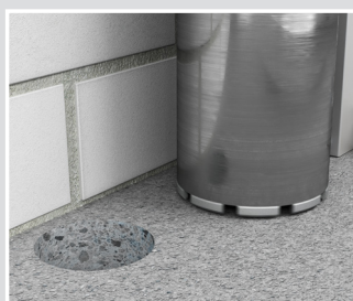
...oder passende Kernbohrung bei nachträglichem Einbau erstellen..
