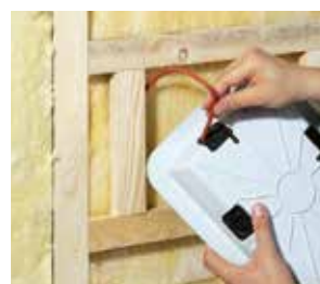
Mit innenliegendem Wechsel. Montage avant pare-vapeur.
