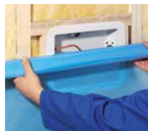
Mit innenliegendem Wechsel. Montage avant pare-vapeur.
