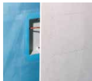
Mit innenliegendem Wechsel. Posa prima della barriera anti-vapore
