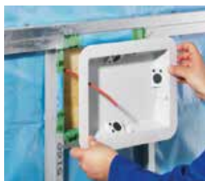
Mit aufliegenderm Wechsel. Posa dopo la barriera anti-vapore
