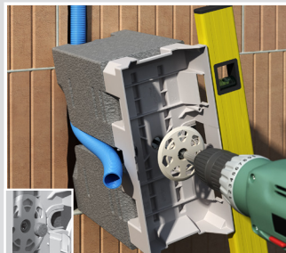
Geräteträger an die Wand halten, ausrichten und mit Dübel befestigen. - Stopfen einsetzen.
