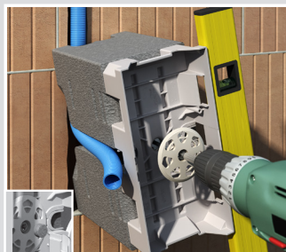
Ajuster le support d'appareils contre la paroi et fixer à l'aide de la cheville à visser. Insérer le bouchon.
