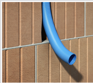
Mur en brique avec sortie de tube.
