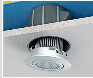
Einsetzen des Strahlers in das Gehäuse.
