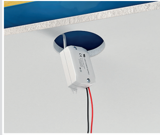
Installation des Betriebsgerätes (Treibers).
