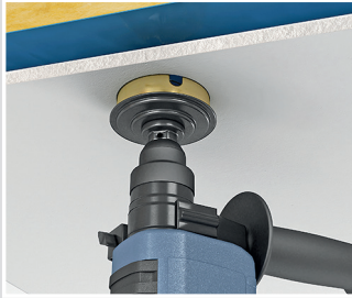
Erstellung der Fräsöffnung (z. B. mit dem Turbofräser Multi 4000 Art. Nr. 1084-10 / E-No 983 228 149)
