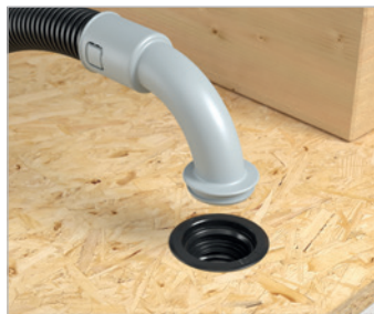
Aufstecken des 90°-Bogens auf das Elektroinstallationsrohr und ...
