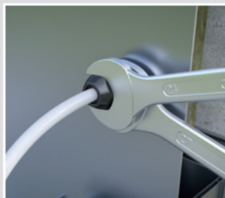
Kabel einziehen und die Druckmutter mit dem Schlüssel festziehen
