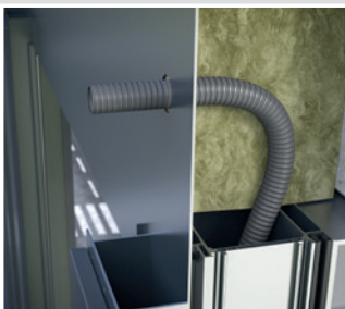
Schutzschlauch (AD 20 - 21.2mm) durch die Fassade führen
