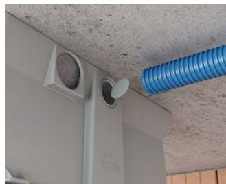
Rohr oder Leitung in das Einbaugehäuse einführen; Rohr mit Dichtstopfen versehen.
