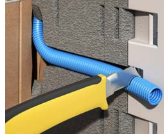
Das Rohr in die seitliche Führung drücken und ablängen.
