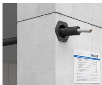
Wanddurchführung durch Brandschutzwand aus Kalksandstein.
