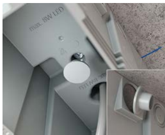
Einbaugehäuse an die Decke schrauben und Abdeckung der Schraube montieren.
