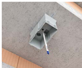
Alternativ: Einbaugehäuse mit den Ausrichtmarkierungen für die Leuchte positionieren und Bohrloch anzeichnen.
