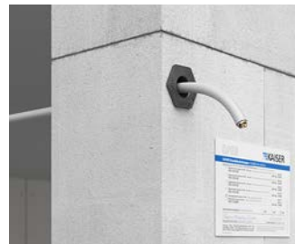
Wanddurchführung durch Brandschutzwand aus Kalksandstein.
