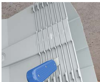
Einbaugehäuse an die gemessene Dämmstärke anpassen.
