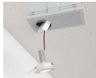
Anbringen der Dämmung und Putz. Montage des LED Einbaustrahlers mit reichlich Raum für das Vorschaltgerät.
