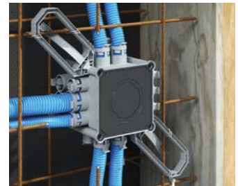
Mit Rödeldraht befestigen und Rohre einführen.
