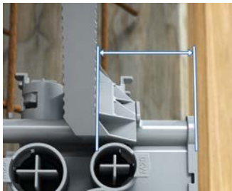
Überprüfung der Beton-Überdeckung.
