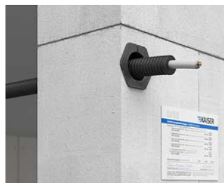
Passaggio attraverso muro antincendio in arenaria.
