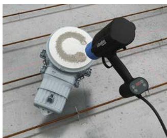
Montaggio della scatola monoblocco con piastra in fibre minerali...
