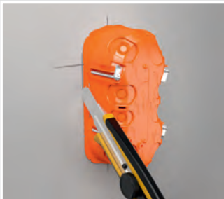
Utiliser les bords de la boîte pour inciser la plaque légèrement
