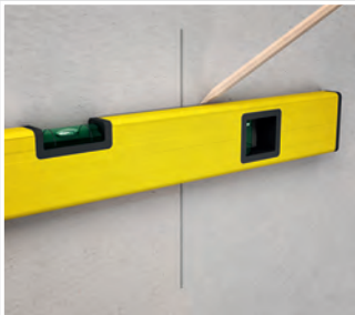
Positionner le centre de forage
