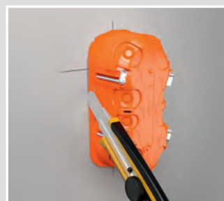
Gebruik buitenrand van de doos om plaatmateriaal licht in te snijden.
