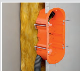
Doos met brede rand aanbrengen in de inbouwopening.
