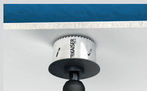
Maken van de inbouwopening Ø 68 – 80 mm.
