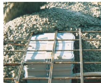
Installation fiable et stable du boîtier lors du bétonnage.
