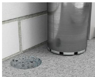
Forage avec carottage d'un trou de 150 mm ou 100 mm.
