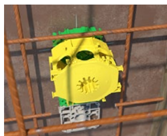
...fermez la partie arrière avant d'insérer les tubes.
