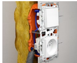
Monter l'appareillage.
