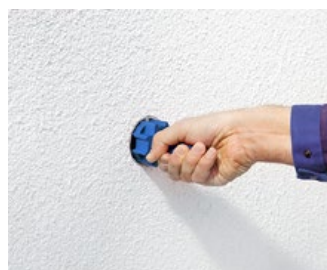
Grâce à l'outil de fixation Styro-55, les arpillons sont rapidement et facilement fixés.
