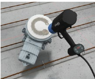
Montage du boîtier en une partie avec plaque en fibres minérales...
