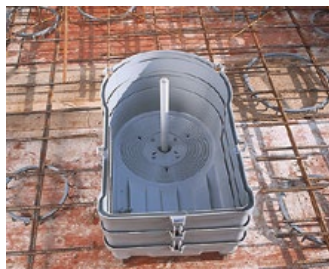
Fixer le boîtier avec les 2 rehausse et le support à l'armature.
