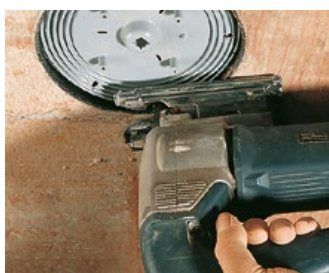
Ouvrir la coiffe avant à l'aide d'une scie à guichet.
