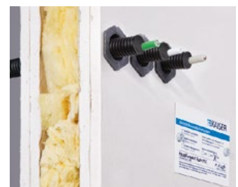
Il est possible de grouper horizontalement ou verticalement des cloisonnements de tubes en respectant un entr'axe de 50 mm.
