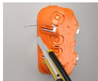
Utiliser le rebord d'appui comme arête de coupe ; entaille superficielle du plâtre cartonné.
