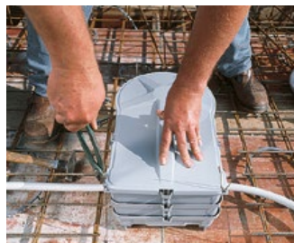
Fixer également le boîtier à l'armature.
