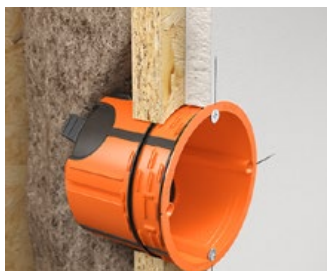
Construction murale en panneaux OSB avec plâtre cartonné.
