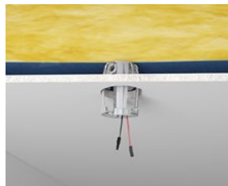
Ouverture d'installation Ø 68 - 80 mm.
