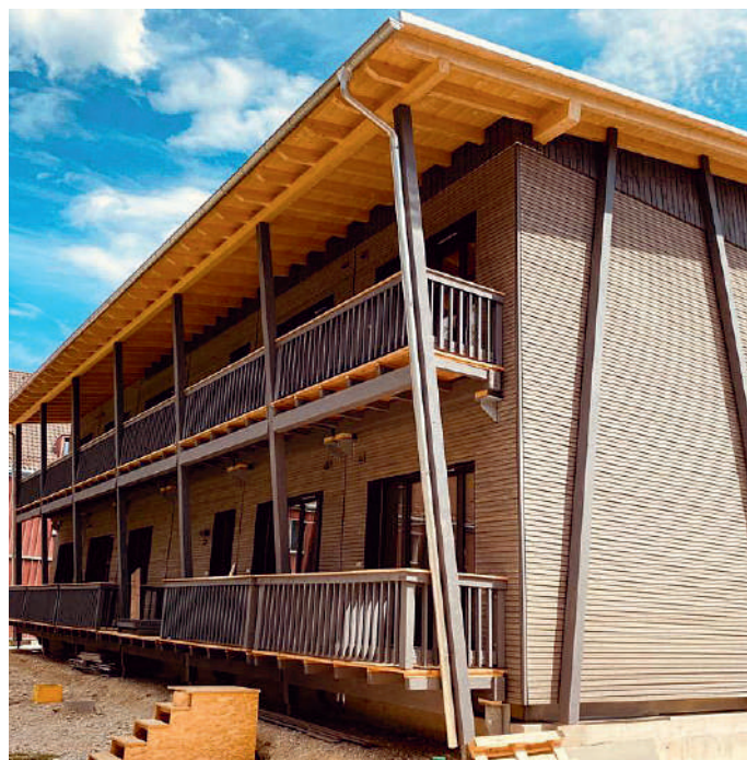
1 In nur fünf Wochen wurde mit 28 Massivholz-Modulen die Erweiterung des Fußballinternats fertiggestellt
