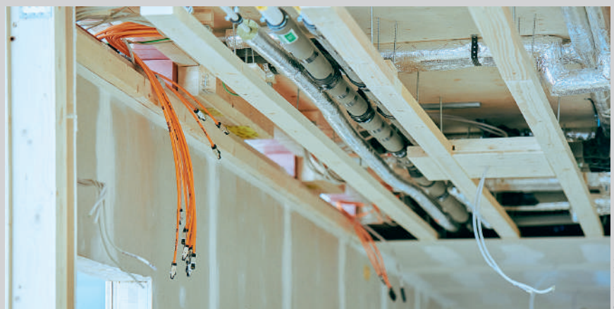
Planexakte Elektroinstallation in der Fertigung
